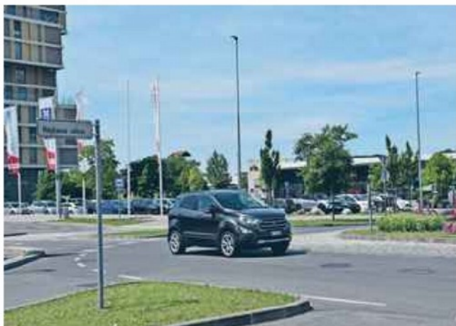
Ena od gradbenih jam bo tudi na krožišču med Rejčevo in Prvomajsko ulico.
